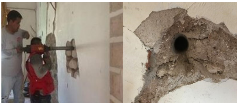
Figura 3.1. Pruebas invasivas o también llamadas destructivas (extracción de corazones) realizadas mediante la obtención de pequeñas muestras de argamasa en un muro de mampostería irregular en la Parroquia de San Agustín Obispo Chiautla de Tapia, Puebla. Fuente propia.
