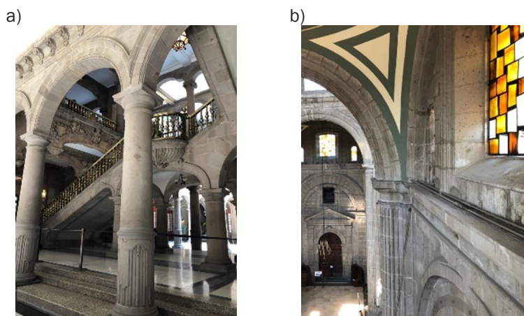
Figura 3.7.1. Tipos de piedra utilizados en elementos estructurales de acuerdo con su morfometría: a) fuste de columna de una sola pieza de piedra; b) arco y columna de sillería (bloques). Fuente propia.
