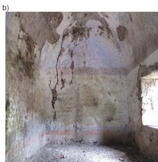
Figura 2.19. Grietas visibles en la parte interior del inmueble: a) grietas generadas posiblemente por la separación de los muros perimetrales paralelos a la bóveda; b) grietas generadas posiblemente por hundimientos diferenciales. Fuente: Retomado de Segovia, M. A. (2022).
