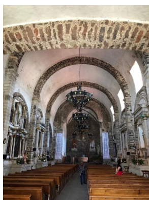
Figura 3.7.2. Tipos de piedra utilizados en elementos estructurales de acuerdo con su morfometría. Arco de piedra irregular con argamasa (mortero). Fuente propia.
