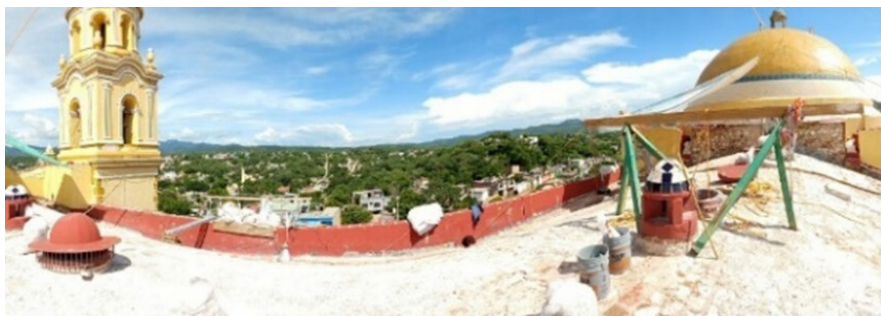
Figura 1.1. Intervención física en la Parroquia de San Agustín Obispo, Chiautla, Puebla, 2018. Retiro de impermeabilizante e inspección del sistema constructivo en bóveda. Fuente: propia.
