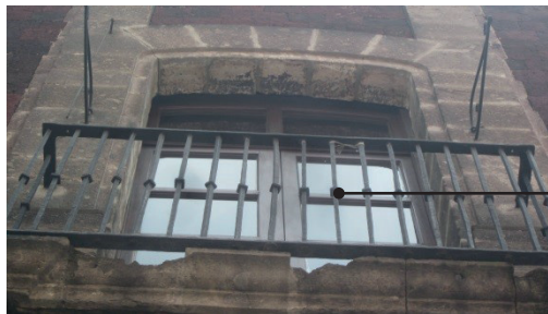
Figura 68. Segundo tipo de barandal que se encuentra en el balcón exterior de la Calle de República del Salvador. Balaustres o barrotes de sección cubo con adorno cuadrado en el centro.
