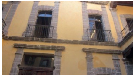
Figura 105. Forma en la que se muestra después del retiro del pasillo sur que no formaba parte de la obra arquitectónica original.
