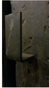
Figura 88. Cerrojo para cerrar la parte inferior de los portones con tiras de madera.
