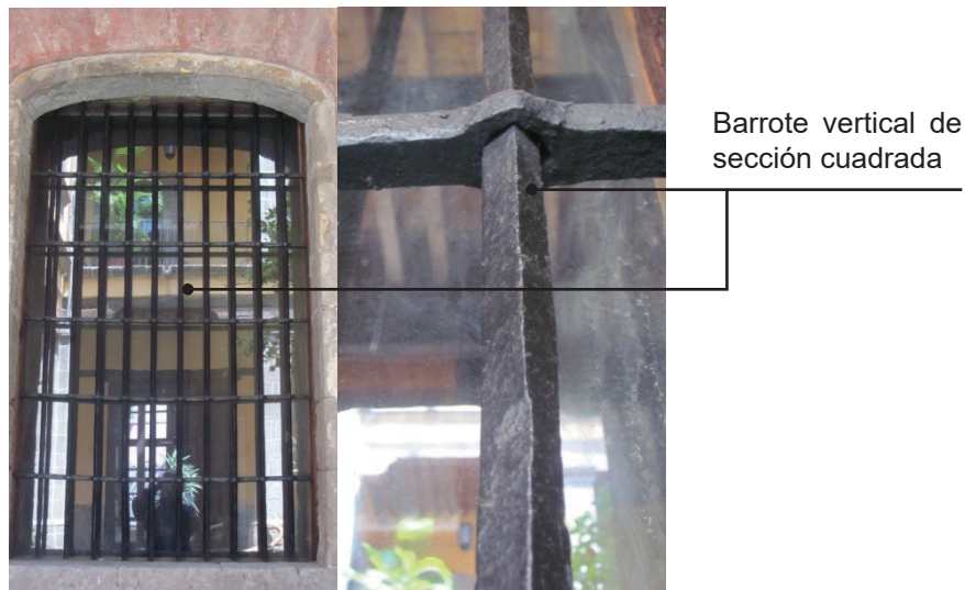
Figura 73. Reja con barrotes verticales de sección cuadrada, en el interior de la Casa Talavera.
