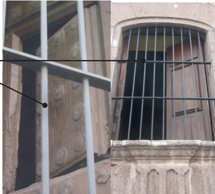
Figura 74. Rejas de barrotes con sección cilíndrica, ubicadas en dos ventanas al exterior de la planta baja de la Casa Talavera, en la calle de República del Salvador.
