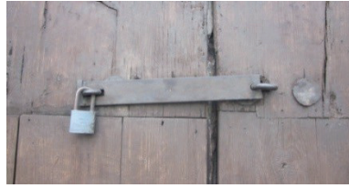
Figura 85. Cerradura para exteriores aplicada.
