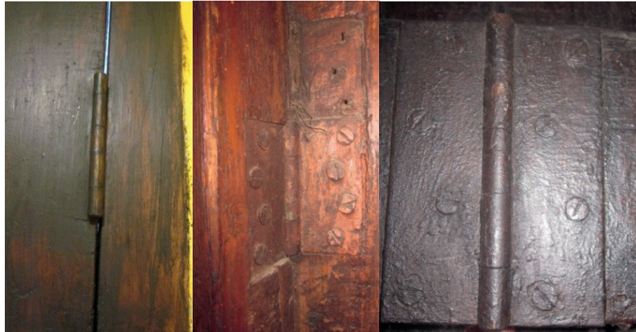
Figura 81. Bisagras colocadas en ventanas pertenecientes a la casa Talavera, este elemento es moderno.
