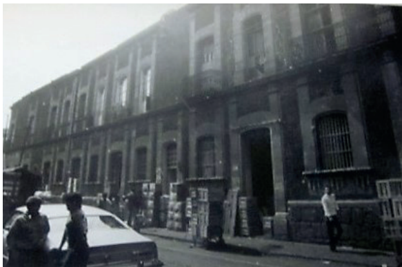
Figura 16. Fachada del inmueble de casa Talavera en la calle de República del Salvador 187-191, como se observa, conserva todos sus elementos originales en regular estado, cuando funcionaba como bodega. Fuente: Pertenece a la colección de las fotos de Gustavo Casasola (Casasola, 2013: 1376) retomado en la inspección de 1970 (ACNMH, 1970) 52 .
