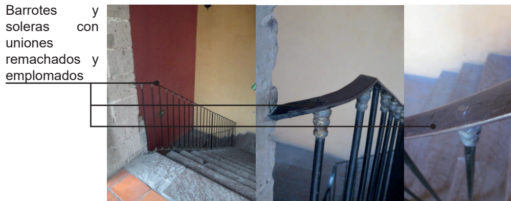
Figura 70. Tercer tipo de barandal en la escalera de la entrada.
