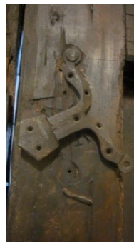
Figura 86. Fragmento de un cerrojo colocado en la cubierta de una puerta en su lado interior, faltante el resto del mismo en la otra puerta.
