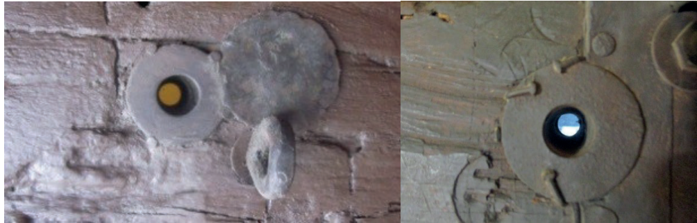
Figura 94. Mirilla que se encontró en una puerta de la Casa Talavera.
