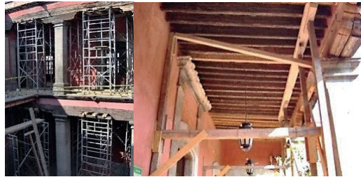
Figura 101. Trabajos previos a la restauración: apuntalamiento de techos, muros, pilas, zapatas y gualdras, así como la colocación de andamios para el retiro de materiales a sustituir en las pilas al oeste del primer patio en la planta baja y alta.
