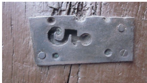
Figura 92. Fragmento de una bocallave del tipo de placa cuadrada reutilizada en una puerta correspondiente a la del No. 5.
