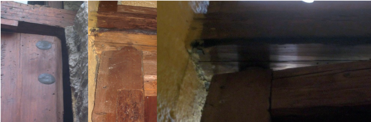
Figura 80. Espigones y quicios en la parte alta del dintel de algunas puertas de la casa Talavera que les permitió tener movilidad para abrirlas y cerrarlas.
