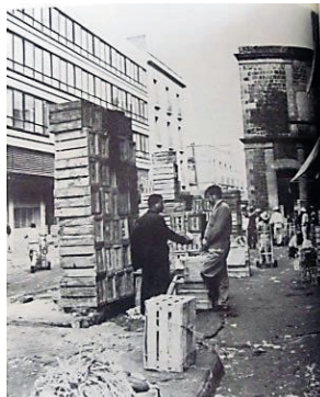
Figura 15. Bodega en la Calle Talavera No.20 esquina lado Suroeste tomada en el año 1957. Obtenida de Fotos de Valencia (Valencia 1965:20611) 51 .
