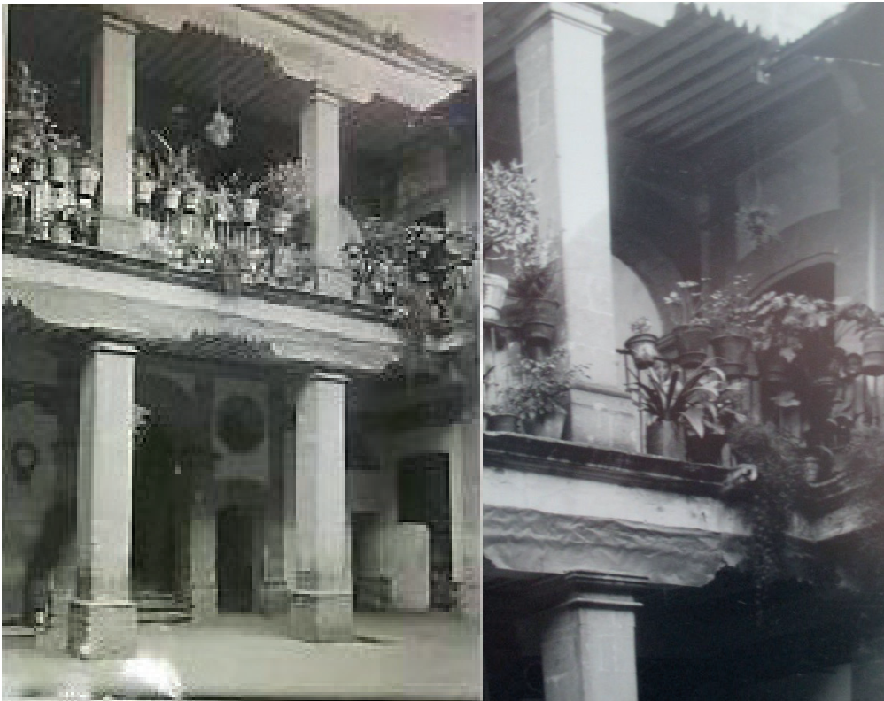
Figura 98. Vista del lado Este del primer patio, cuando la casa es una escuela primaria, y se ubica al sur un pasillo añadido, después (2013) retirado.
