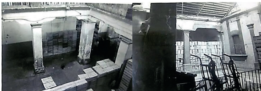
Figuras 18 y 19. Vista del patio oeste en casa Talavera, que funcionaba como bodega cuando se realizó una inspección por Monumentos Históricos en 1970. Fuente: Fotos de la inspección de 1970 (ACNMH 1970).
