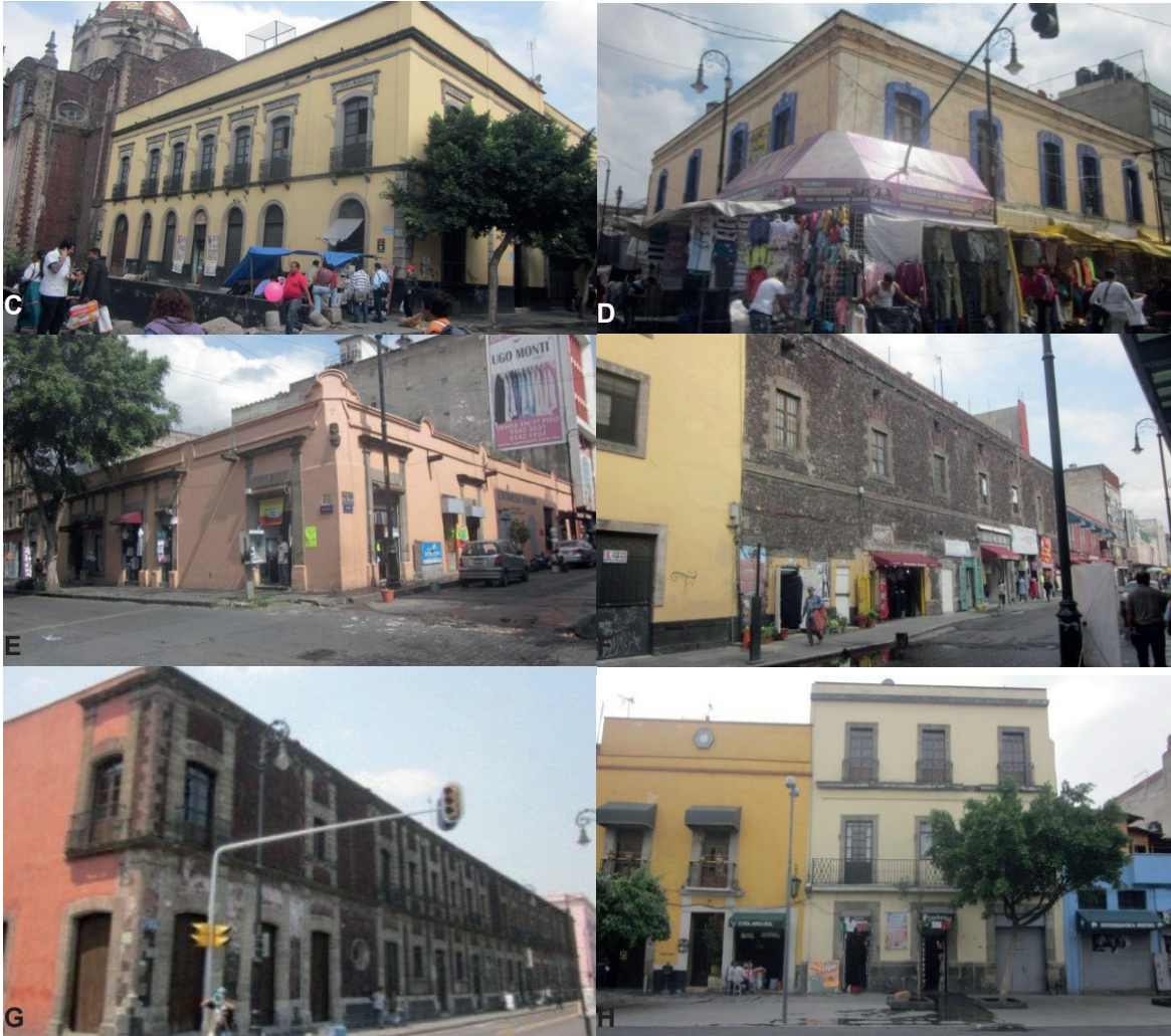
Figura 45. Construcciones utilizadas como curtidurías en los barrios de San Sebastián y San Pablo, actualmente algunos inmuebles como Casa Talavera conservan sus materiales de construcción de muros de tezontle y jambas y dovelas de cantera que limitan los vanos de puertas y ventanas.
