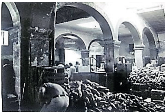
Figura 25. Vista de lo que fue el patio Este usado como bodega, los muros fueron demolidos (datos de la inspección de 1970 por Monumentos Históricos. Fuente: Fotos de la inspección de 1970 (ACNMH, 1970).
