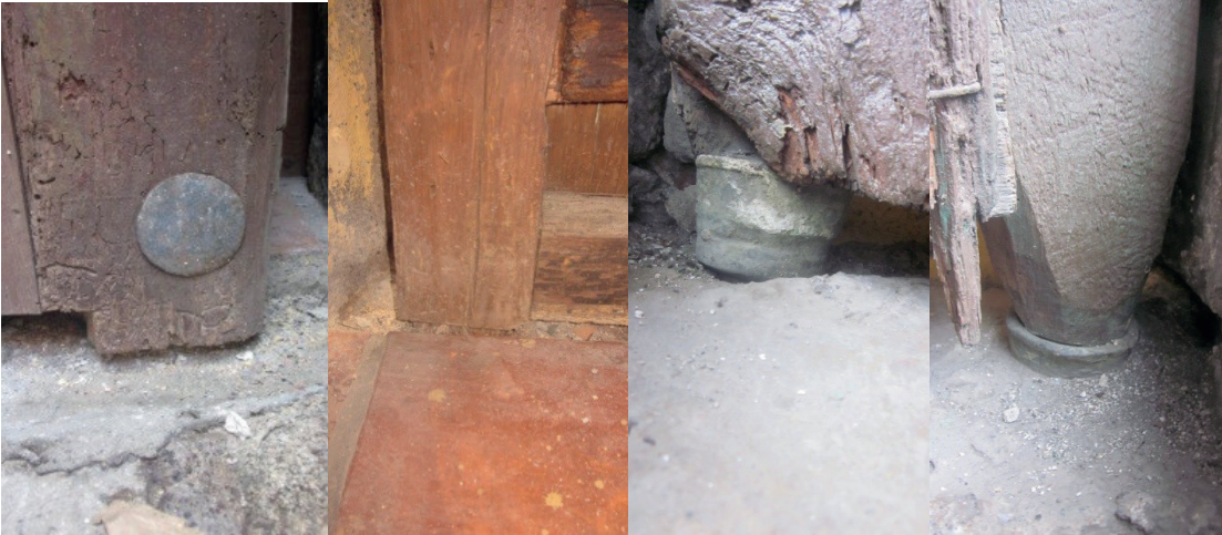
Figura 79. Espigones y quicios en la parte baja de algunas puertas de la casa Talavera que les permitió articularlas para abrirlas y cerrarlas.
