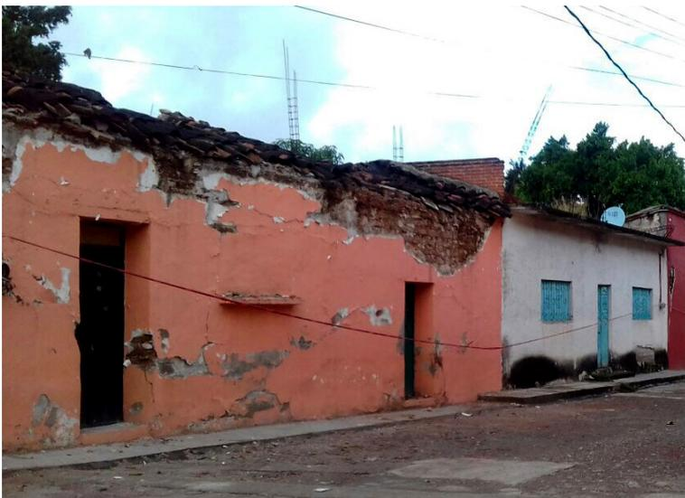
Figura 6. Revoque de cemento desprendido de las paredes de adobe, Ixcamilpa de Guerrero, Puebla [foto *Proyecto Geografía histórica de la Mixteca Baja*, ENAH, 22 septiembre de 2017].
