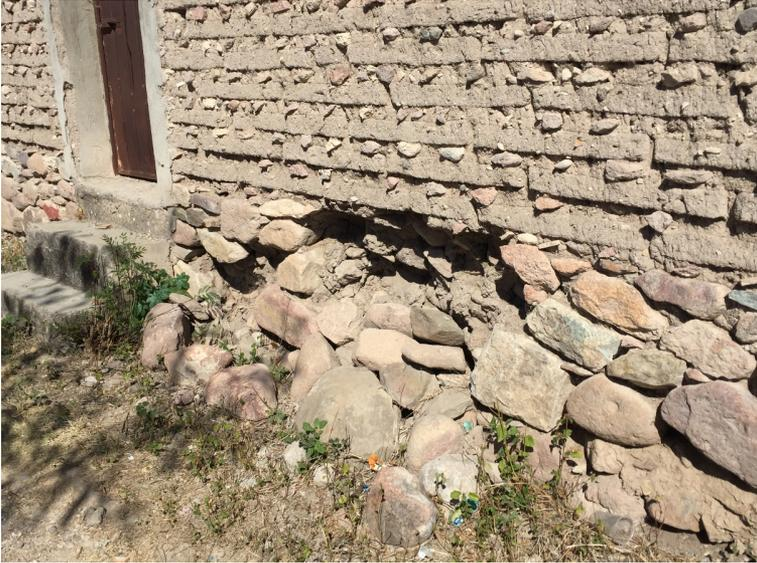
Figura 82. La presencia de zócalos de piedra asentada con morteros de barro como base para los muros de adobe, garantiza la correcta transferencia de cargas y evita la ascensión capilar de agua, Ayoxuxtla, Puebla [foto: L. Guerrero].
