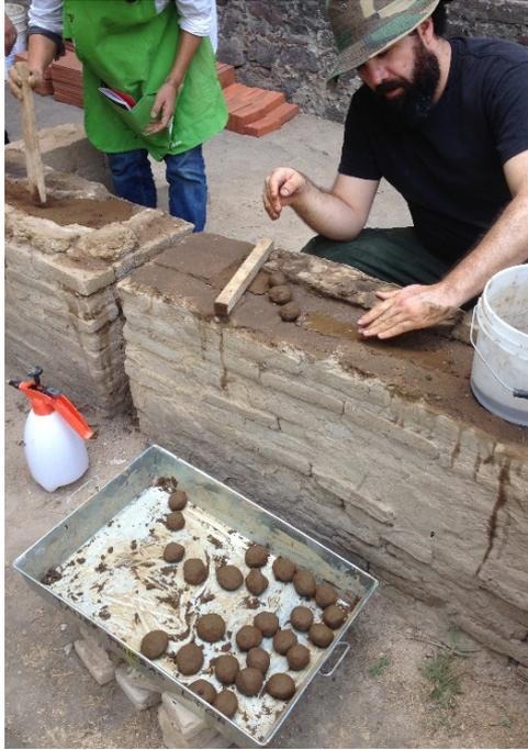
Figura 90. Se elaboran esferas con tierra lo más parecida posible a la del sustrato original y sólo con la humedad necesaria para darles forma. Los huecos y grietas deben saturarse de humedad previamente, CNCPC-INAH, CDMX, [foto: L. Guerrero].
