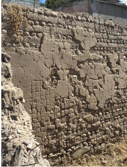
Figura 86. Restos de recubrimientos de tierra en las caras interiores de los muros de una vivienda en ruinas, Huehuetlán el Chico, Puebla [foto: L. Guerrero].
