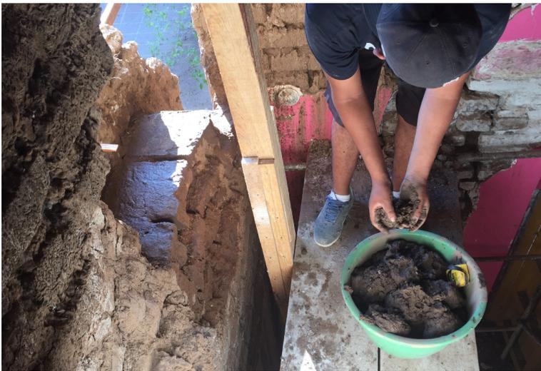
Figura 81. El mortero utilizado para la reposición de adobes se hizo reciclando los materiales originales del muro que colapsó con el sismo, Ixtepec, Oaxaca [foto: L. Guerrero].
