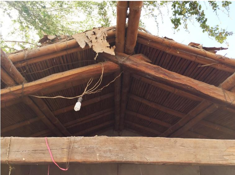
Figura 84. Los sistemas de cubierta tradicionales están atadas o “simplemente apoyados”, es decir, tienen libertad de movimiento durante las cotidianas contracciones y dilataciones derivadas de los cambios de humedad y temperatura, Huehuetlán el Chico, Puebla [foto: L. Guerrero].
