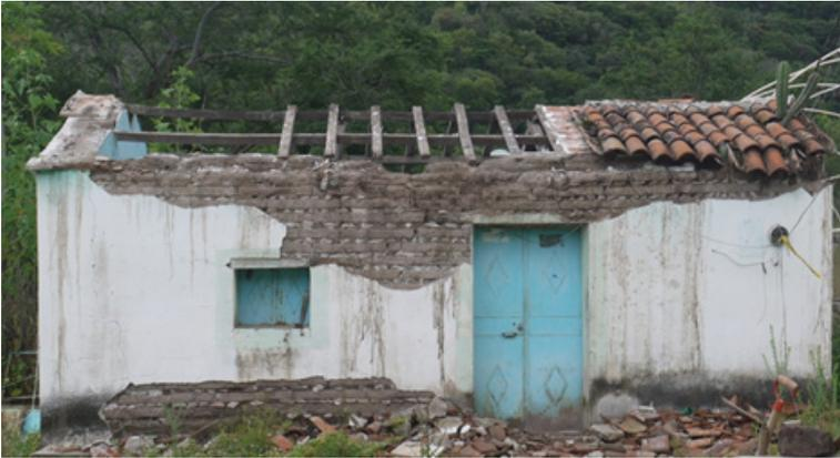
Figura 2. Construcción con techo de dos aguas dañada, Zepatlá, Cohetzala, Puebla [foto Proyecto Geografía histórica de la Mixteca Baja, ENAH, 7 octubre de 2017].
