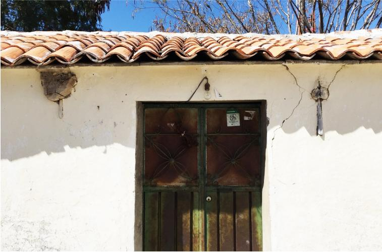
Figura 88. En ambos lados del dintel de la puerta asoman los cabezales de los tirantes correspondientes al nudillo de los tijerales que atraviesan ambos muros y que, para evitar su desplazamiento, conservan pasadores verticales llamados “clavijas”, Huehuetlán el Chico, Puebla [foto: L. Guerrero].
