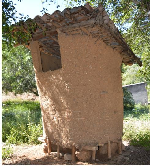
Figura 104. Troje con la técnica de cuajiloteo y recubrimiento de lodo en Axutla, Puebla [foto Alejandro Pantaleón Calixto, 2017].
