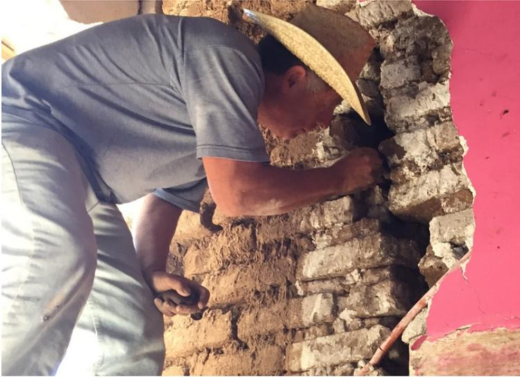
Figura 91. Las esferas se insertan cuidadosamente y luego se presionan hasta perder su forma y convertirse en una capa que debe endurecer antes de colocar la siguiente, Ixtepec, Oaxaca [foto: L. Guerrero].
