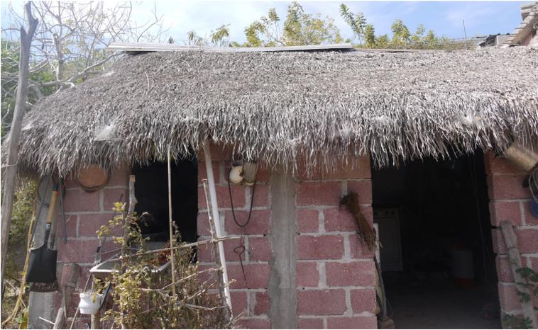
Figura 29. Techo tejido de palma utilizado anteriormente para las construcciones de bajareque, Santa Mónica, Cohetzala, Puebla [foto *Proyecto Geografía histórica de la Mixteca Baja*, ENAH, 1 de diciembre del 2017].
