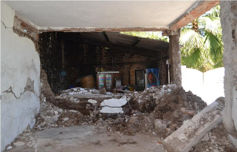
Figura 78. Los componentes de concreto armado alteran la forma natural de interacción de los muros de adobe con los techos, destruyéndolos en los sismos, Huehuetlán el Chico, Puebla [foto: acervo *Proyecto Geografía histórica de la Mixteca Baja*].
