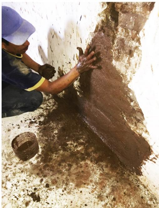
Figura 89. Reintegración de un aplanado con tierra en lugar de cemento, Ixtepec, Oaxaca [foto: L. Guerrero].
