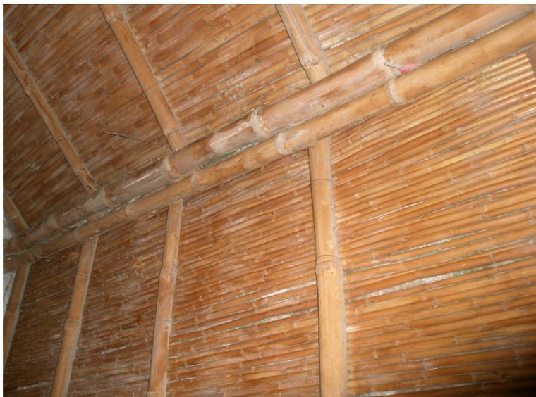
Figura 43. Techado con ocotate y acilina en el barrio de Guadalupe, Huehuetlán el Chico, Puebla [foto Hernández, 2017].
