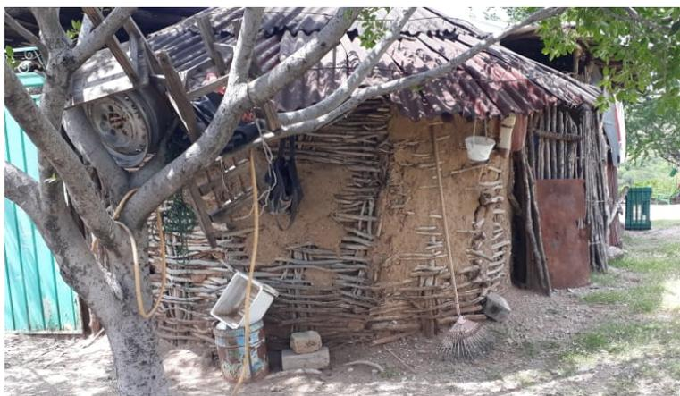
Figura 103. Casa cuajilotada y recubierta de lodo en Jaulillas, Tehuiztingo, Puebla [foto Alejandro Pantaleón Calixto, 2017].
