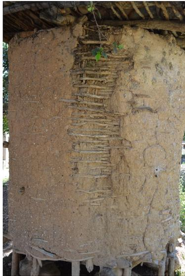
Figura 105. Detalle de la técnica de cuajiloteo y recubrimiento de lodo en una troje en Axutla, Puebla [foto Alejandro Pantaleón Calixto, 2017].
