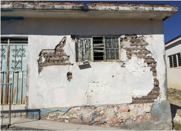
Figura 77. Los productos comerciales generan obras inconexas con el clima local y resultan incompatibles con el comportamiento estructural del adobe, Ayoxuxtla, Puebla [foto: L. Guerrero].
