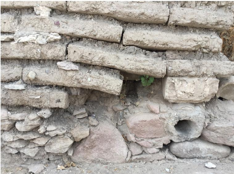
Figura 85. La elevada cantidad relativa de zacate picado que contienen los adobes permite que se deformen sin llegar a romperse, Huehuetlán el Chico, Puebla [foto: L. Guerrero].
