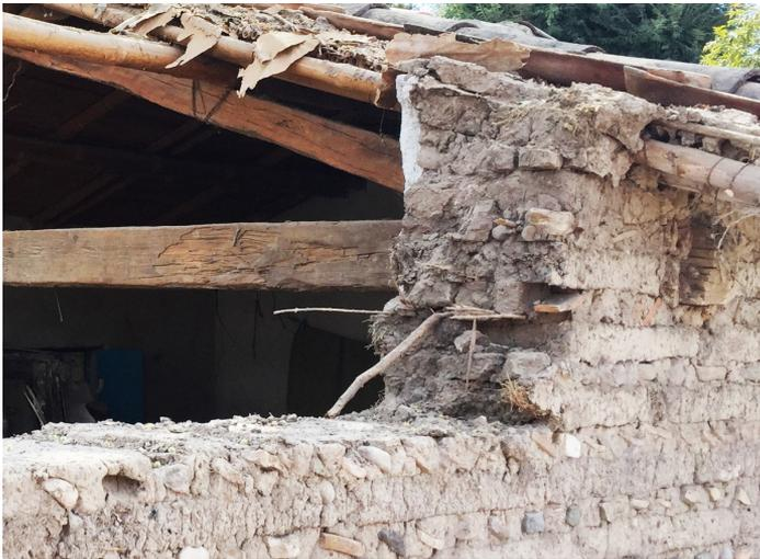
Figura 83. Detalle de un muro de adobe colapsado en el que se pueden observar cortadas las varas que corrían ahogadas a todo lo largo de las juntas entre los adobes, Huehuetlán el Chico, Puebla [foto: L. Guerrero].
