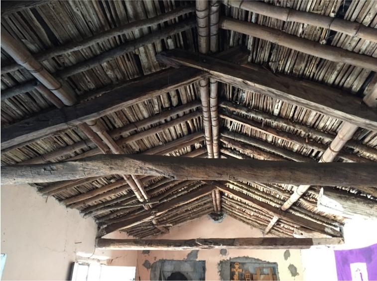
Figura 87. En esta habitación se observa la estructura del techo de madera y ocotates que es reforzada por dos armaduras de madera maciza en forma de "A" con una cruceta superior que sirve para cargar la cumbre, Ayoxuxtle, Puebla [foto: L. Guerrero].
