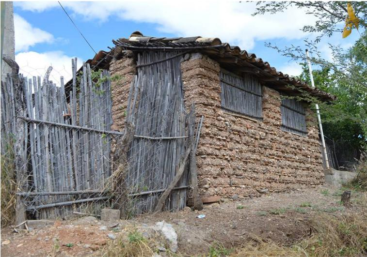
Figura 99. Bardas o cercos elaboradas con la técnica de chinamite en San Jerónimo Xayacatlán, Puebla [foto Alejandro Pantaleón Calixto, 2017].
