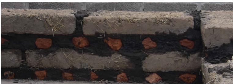
Figura 97. Colocación de hileras de adobe y rejoneado
