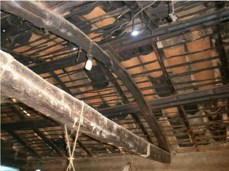
Figura 44. Tirantes, ocotates y tejas para el techo en una cocina del barrio de Guadalupe, Huehuetlán el Chico, Puebla [foto Hernández, 2017].
