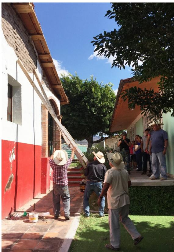
Figura 94. Retiro de los puntales inoperantes de un muro del Museo de Zapata, tras el convencimiento de la comunidad de que los muros de adobe no estaban dañados, Ayoxuxtla, Puebla [foto: L. Guerrero].
