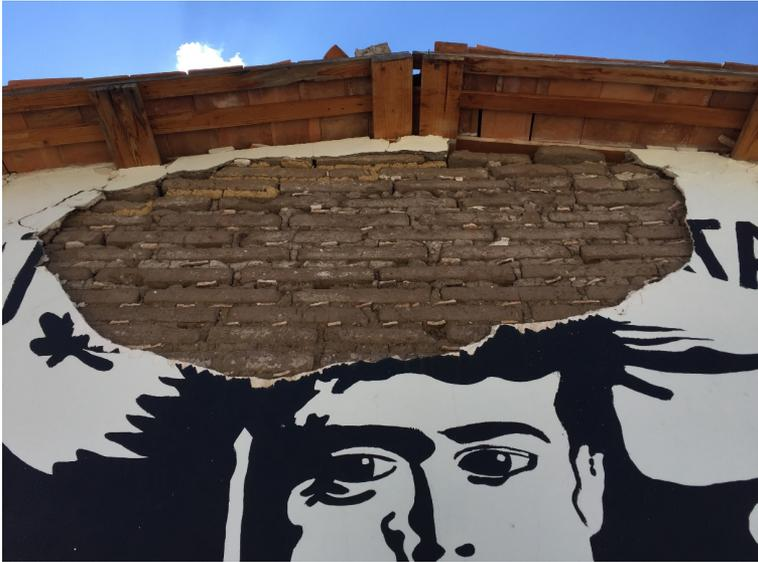
Figura 80. El aplanado de cemento se fracturó y colapsó, pero en el interior los adobes están íntegros, Ayoxuxtle, Puebla [foto: L. Guerrero].
