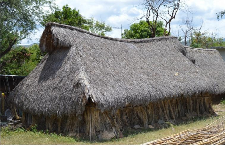
Figura 100. Parte posterior y lateral de una casa de chinamite y techo de palma de dos orejas en San Jerónimo Xayacatlán, Mixteca Poblana [foto Alejandro Pantaleón Calixto, 2017].
