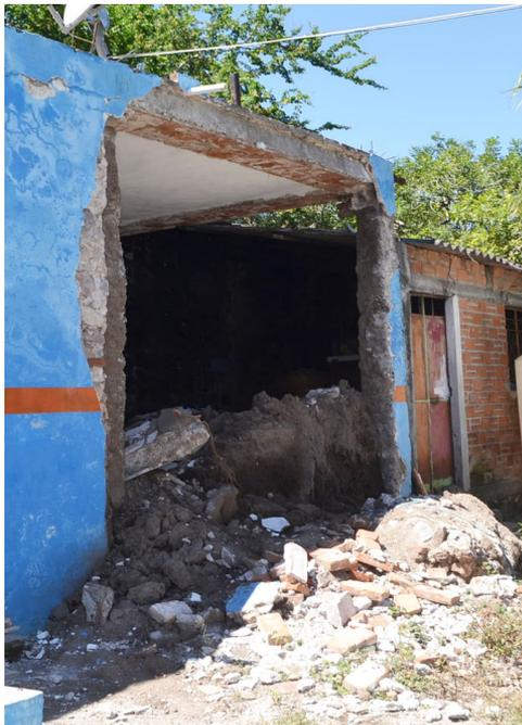
Figura 79. Los castillos de concreto que confinaban el paño de muro de adobe lo golpearon durante el sismo hasta hacerlo colapsar, Huehuetlán el Chico, Puebla [acervo del *Proyecto Geografía histórica de la Mixteca Baja*].
