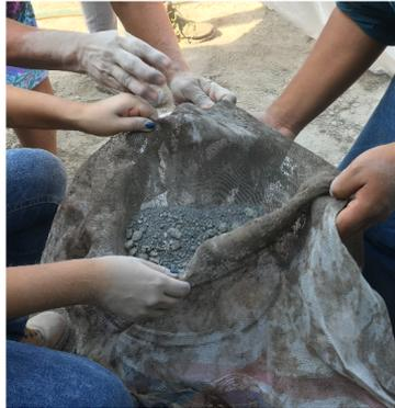
Figura 122. Preparación del barro con agua y cernido de arena
