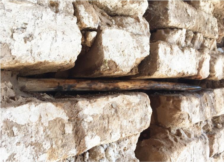
Figura 92. Colocación de una vara de madera de copachín (*Croton niveus*) en la cavidad realizada bajo un adobe fracturado. Detrás de esa pieza ya se introdujo otra vara más, así como las correspondientes capas de esferas de tierra en estado plástico que se compactaron en el interior, Ixtepec, Oaxaca [foto: L. Guerrero].
